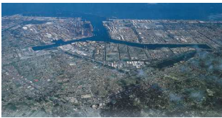
鹿島港 Photo by 鹿島港要覧
